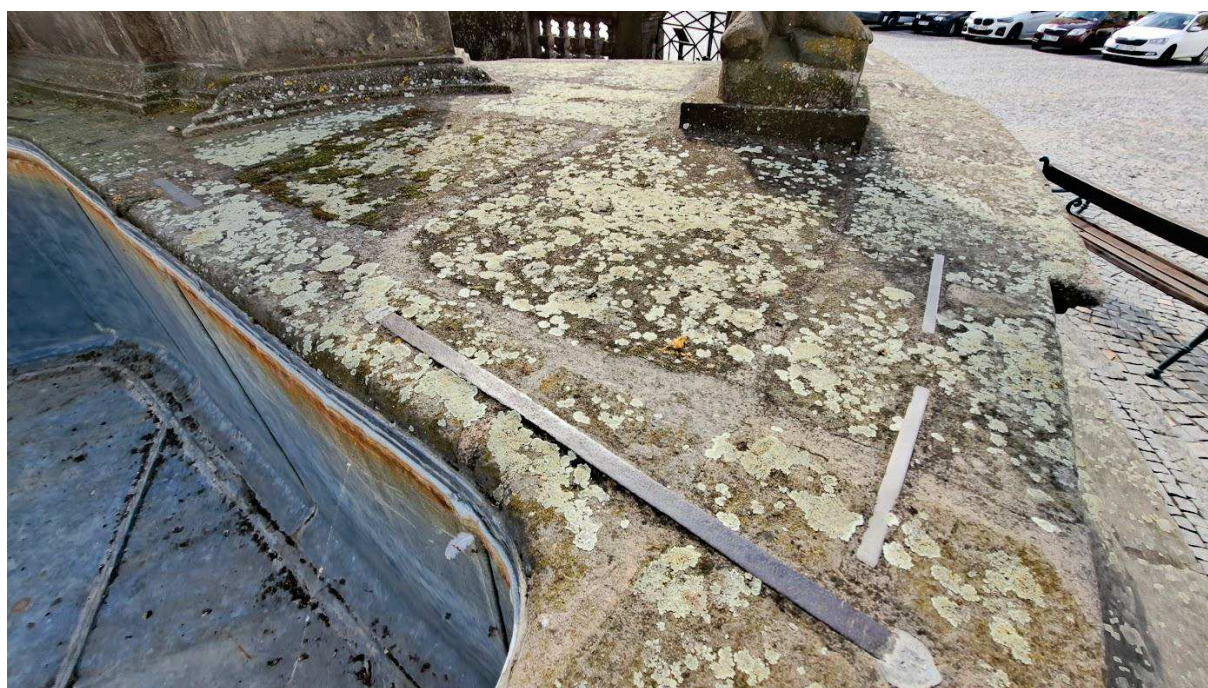
Aktuální poškození na pískovcových prvcích Sloupu Proměnění Páně s kašnou na Resselově náměstí v Chrudimi. Popraskané pískovcové desky. Biologické depozity.
