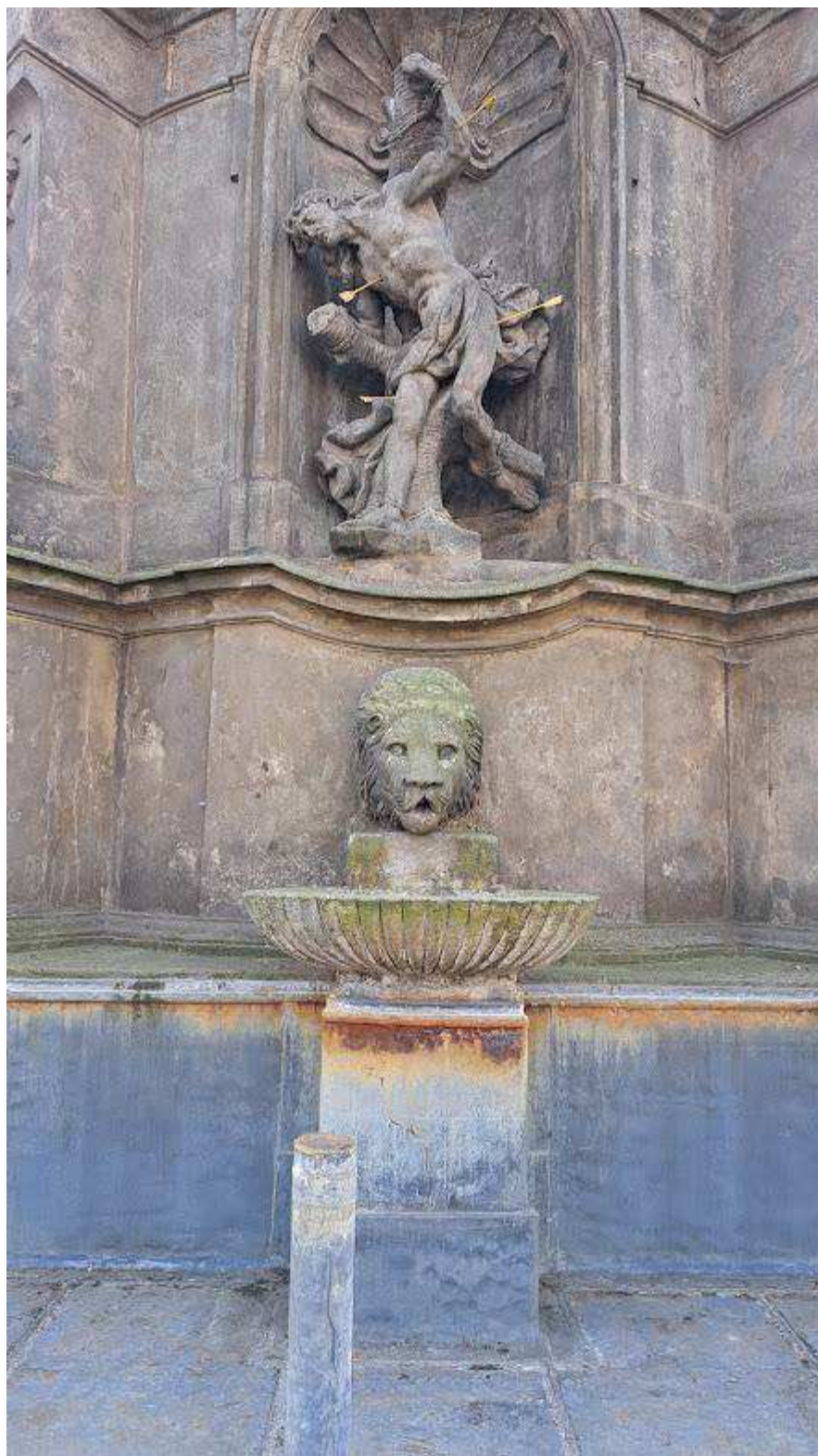
Kašna pod sochou sv. Šebestiána. Zrezavělá výztuha po obvodu olověné izolace.
