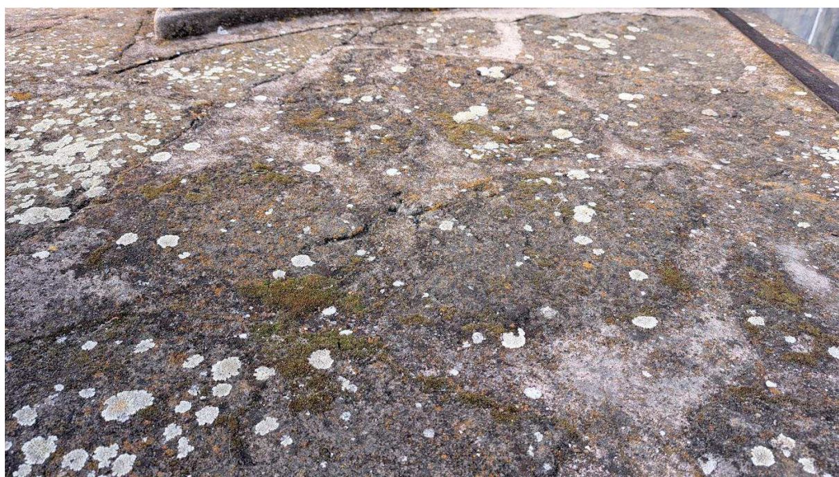
Aktuální poškození na pískovcových prvcích Sloupu Proměnění Páně s kašnou na Resselově náměstí v Chrudimi. Popraskané pískovcové desky.
