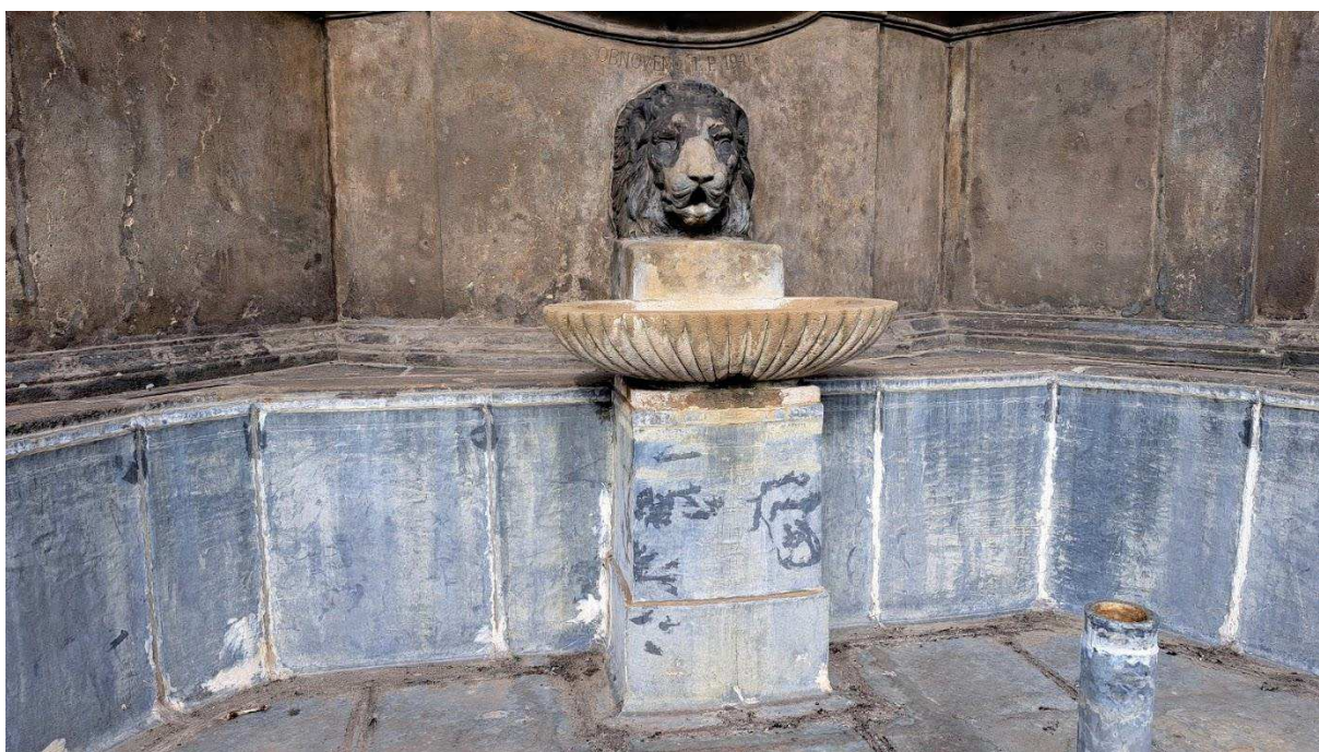
Kašna pod sochou sv. Michaela. Aktuální poškození na pískovcových prvcích Sloupu Proměnění Páně s kašnou na Resselově náměstí v Chrudimi.
