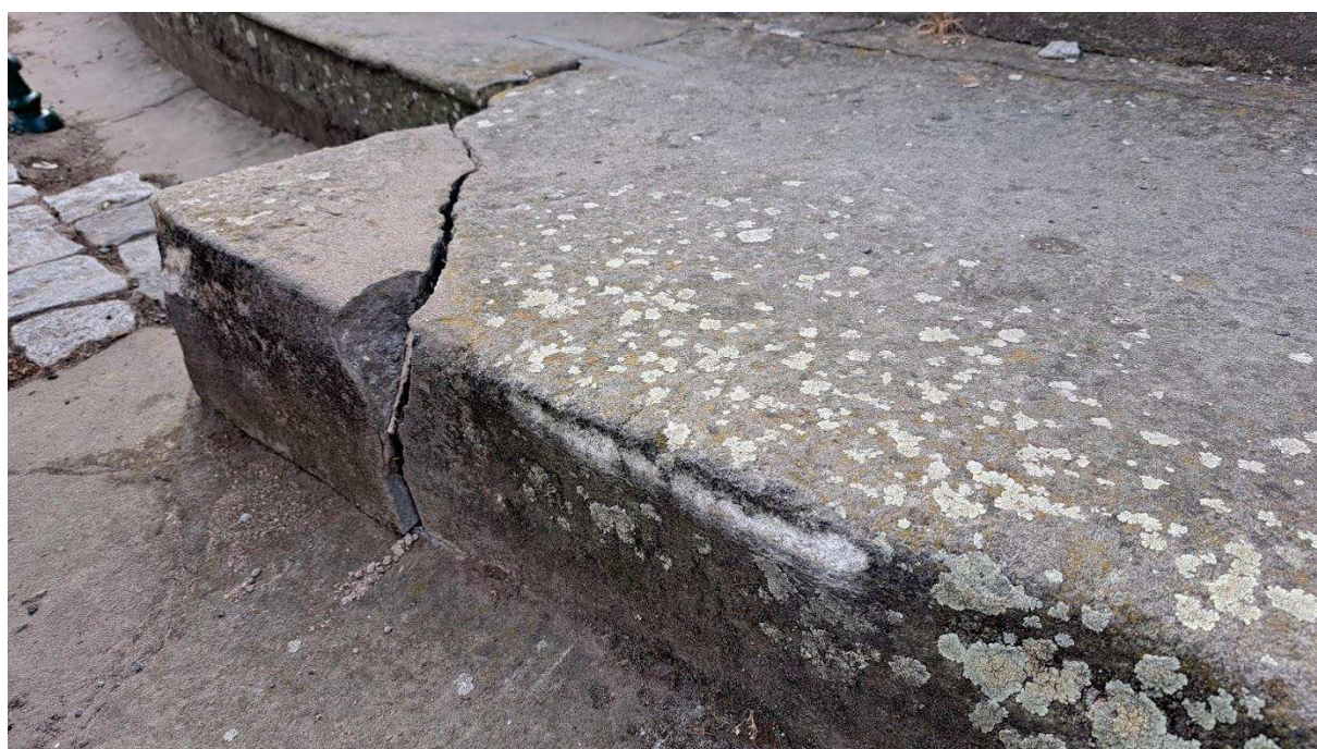
Aktuální poškození na pískovcových prvcích Sloupu Proměnění Páně s kašnou na Resselově náměstí v Chrudimi.
