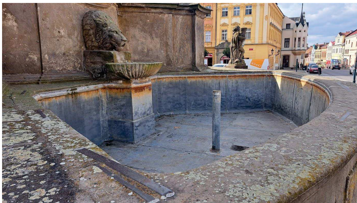
Kašna pod sochou sv. Šebestiána. Zrezavělá výztuha po obvodu olověné izolace. Aktuální poškození na pískovcových prvcích Sloupu Proměnění Páně s kašnou na Resselově náměstí v Chrudimi.
