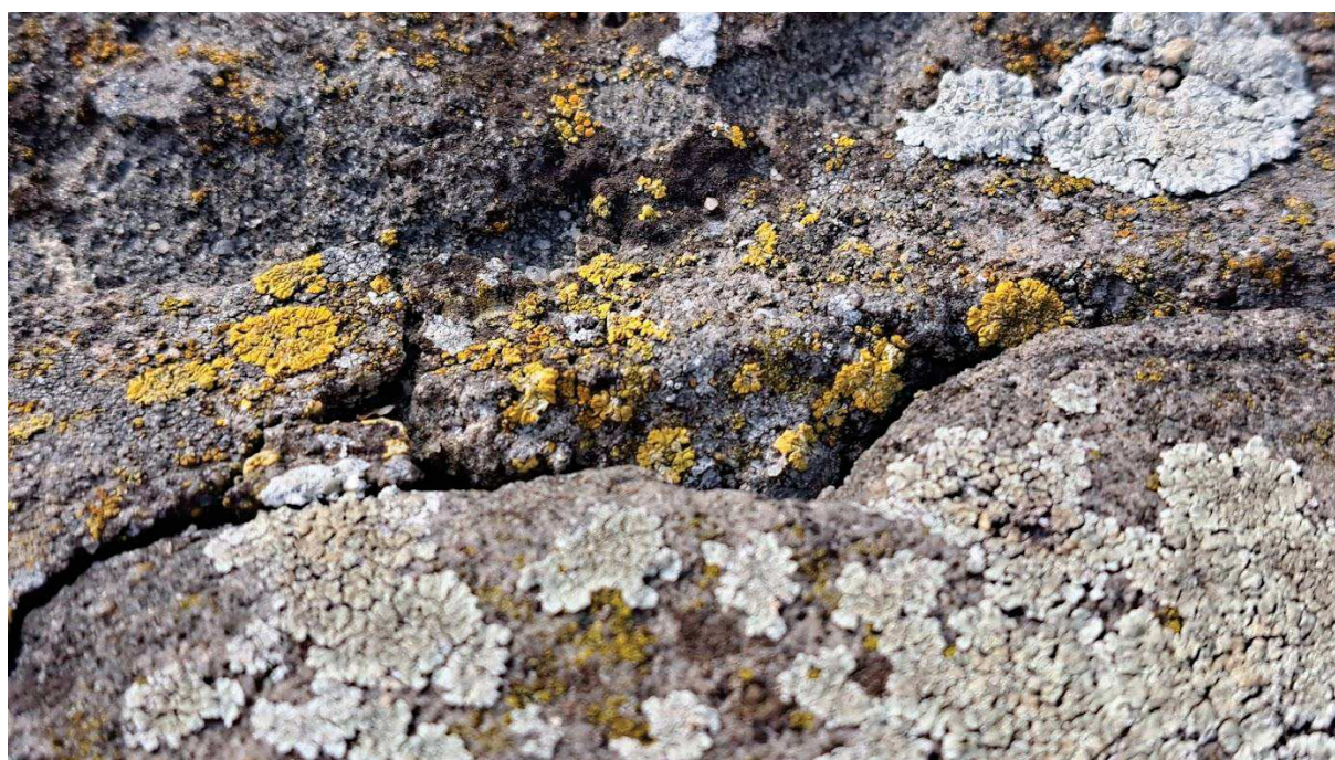
Aktuální poškození na pískovcových prvcích Sloupu Proměnění Páně s kašnou na Resselově náměstí v Chrudimi. Popraskané pískovcové desky. Hlubkové praskliny, vydrolené spáry.
